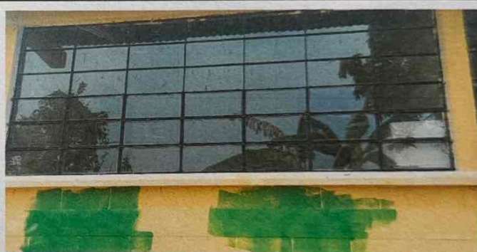
Foto 4: Sustitución de ventana por balcón de bodega 2
