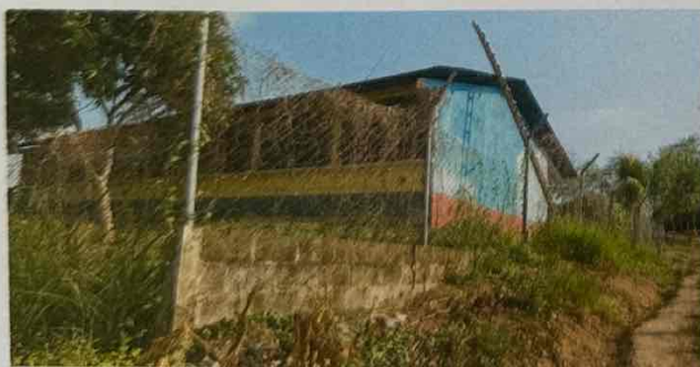
Foto 5: Mantenimiento de muro perimetral 40x27.
