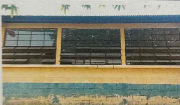
Foto 3: Sustitución de ventanas por balcones aula 1 y aula 2
