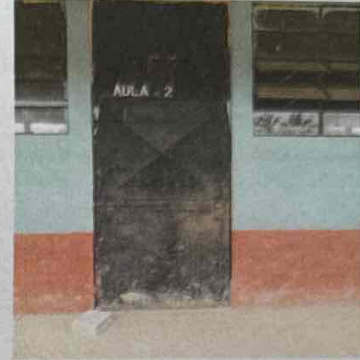
Foto 2: Mantenimiento de puerta.
