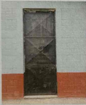
Foto 3: Mantenimiento de puerta.
