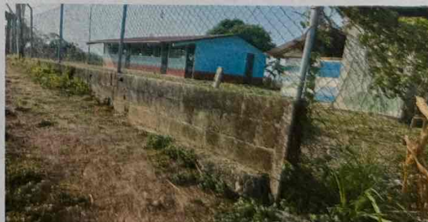
Foto 6: Mantenimiento de muro perimetral
